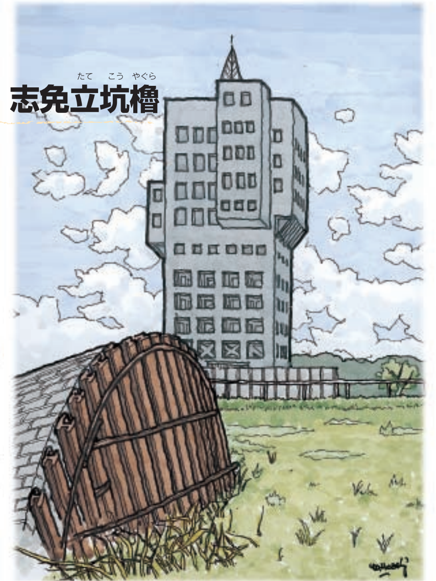
手前は第8坑斜坑で立坑が地下に向かって垂直に掘り進めて行くのに対し横に掘り進められていく。
