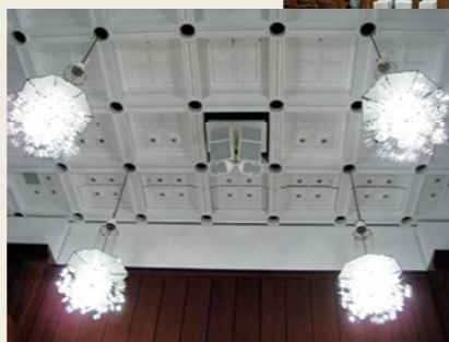
取り替えられた天井部分のスピーカー
