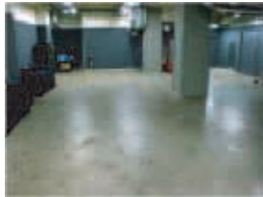
地下2階荷捌き場
