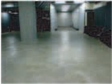
地下2階荷捌き場
