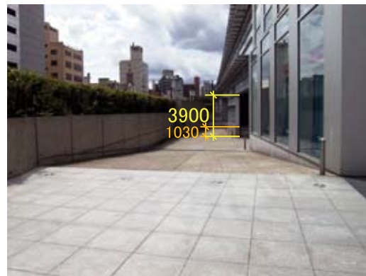
東側荷捌き場
